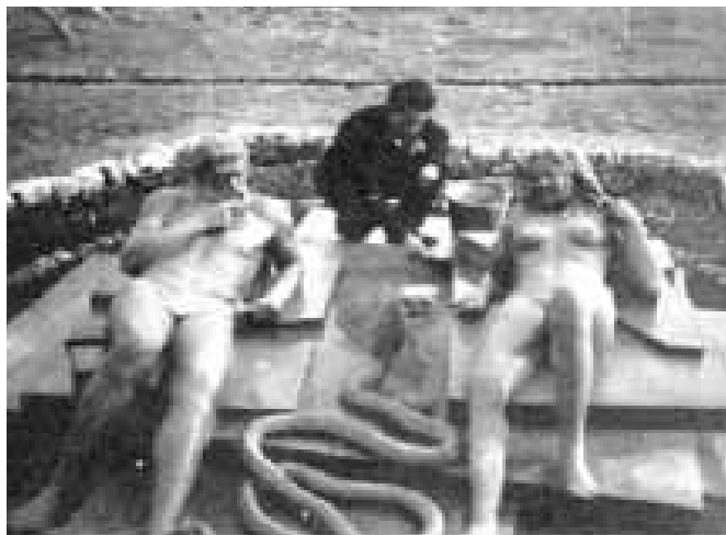
Foto 5 - Neri al lavoro di copertura delle statue
